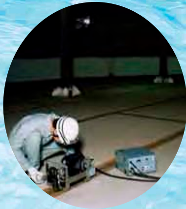
タンク底板非破壊検査 Non-destructive inspection of tank bottom
