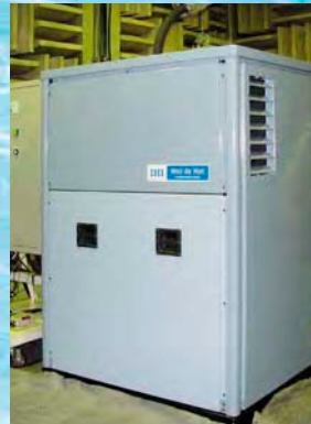
9.9kW石油マイクロディーゼル エンジン・コージェネレーション 9.9kW kerosene type micro diesel engine co-generation
